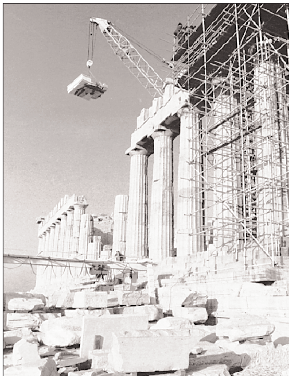
Επανατοποθέτηση του γωνιακού γείσου στη Ν.Α. πλευρά.
