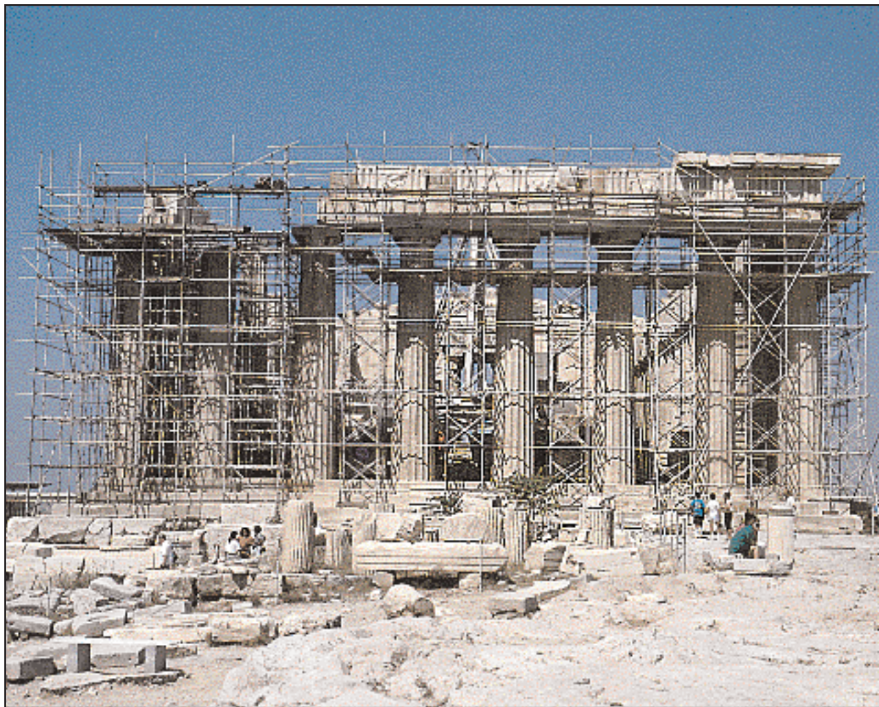
Το μέγιστο σημείο της αποσυναρμολόγησης στο ναό από την ανατολική πλευρά.
