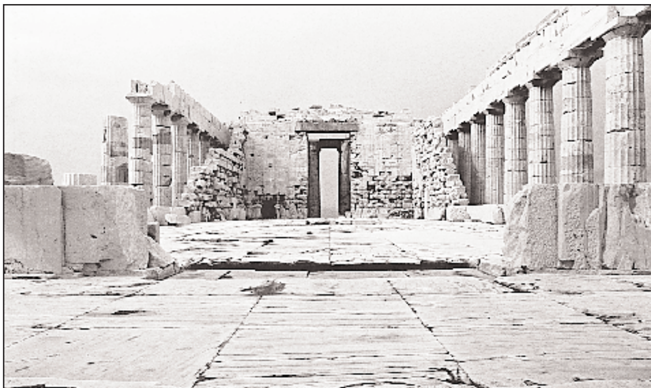
Εσωτερική άποψη του ναού πριν από την έναρξη των εργασιών συντηρήσεως.
